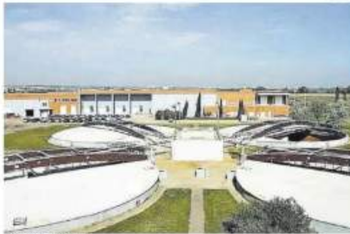
Depuradoras de La Cervera.
